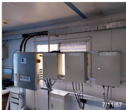
ภาพที่ 25 (ต่อ) การติดตั้งระบบติดตามตรวจสอบการระบายมลสารต่อเนื่อง (CEMs)
